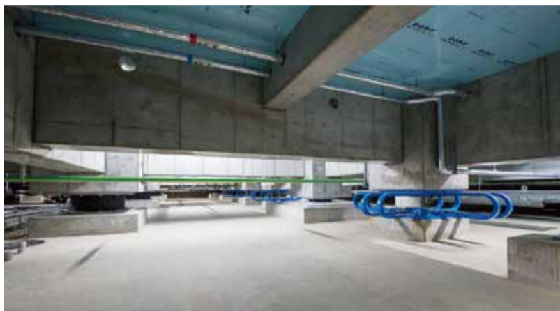
▲免震ピット 免震構造を備えた9階建て
