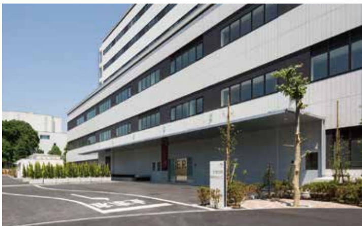
▲ER入口 救急車～ER～検査室・治療室が直結
